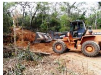
Destape de quebrada
